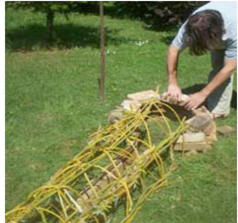
La structure rigide est réalisée sur une longueur de 2 à 2,5 mètres avec des branches de saule que l'on plante dans la terre, les attaches sont en osier ou de la simple ficelle.
